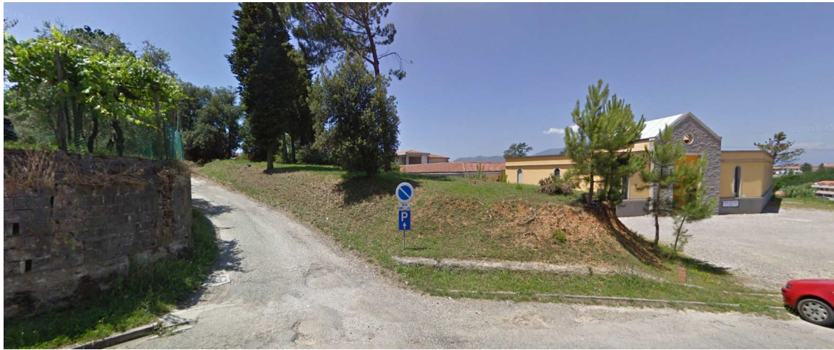
FIGURA 53 – Accesso alla strada che conduce al retro del Cimitero
