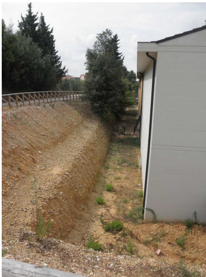
FIGURA 39 – sagomatura terreno effettuata nell'ultimo ampliamento
