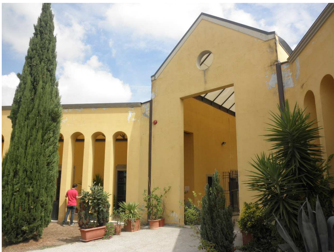
FIGURA 47 – Vista interna al nuovo ingresso
