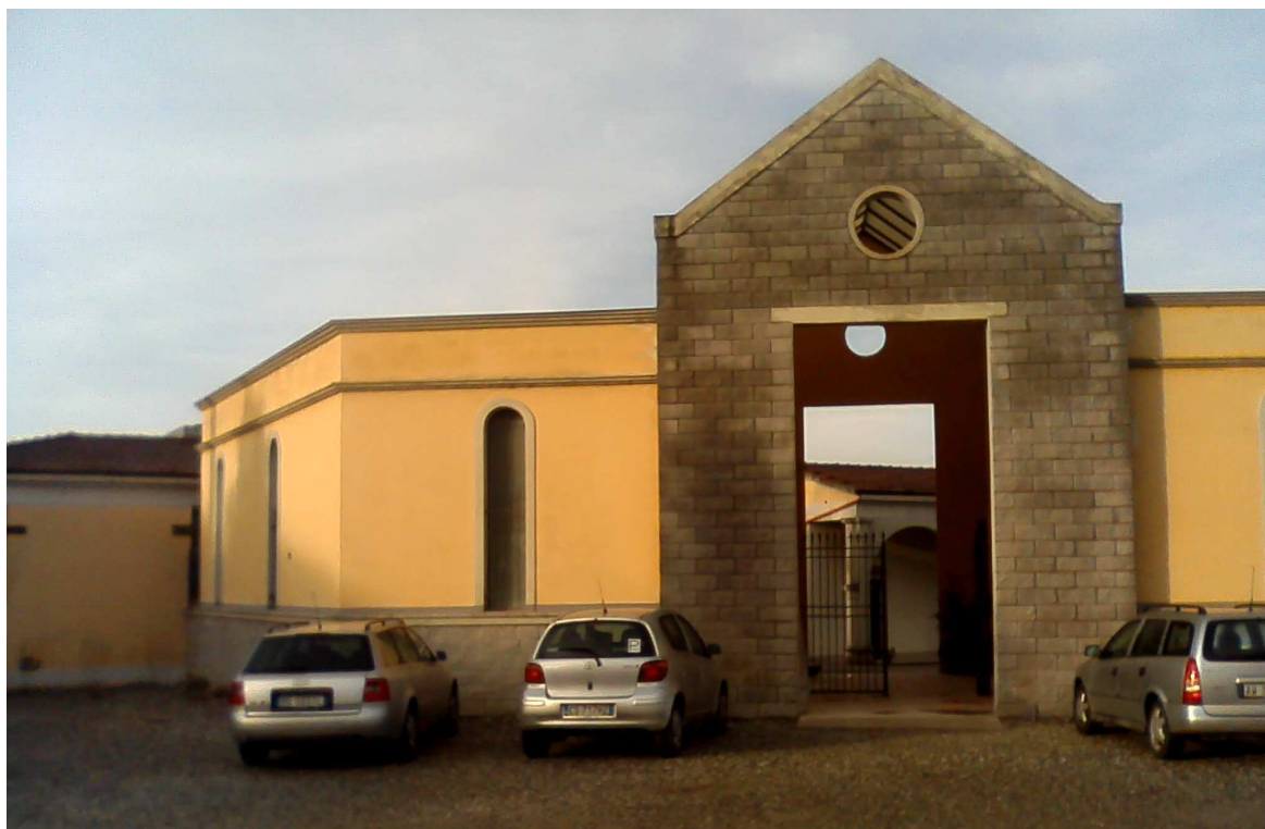
FIGURA 46 – Nuovo ingresso all'area cimiteriale
