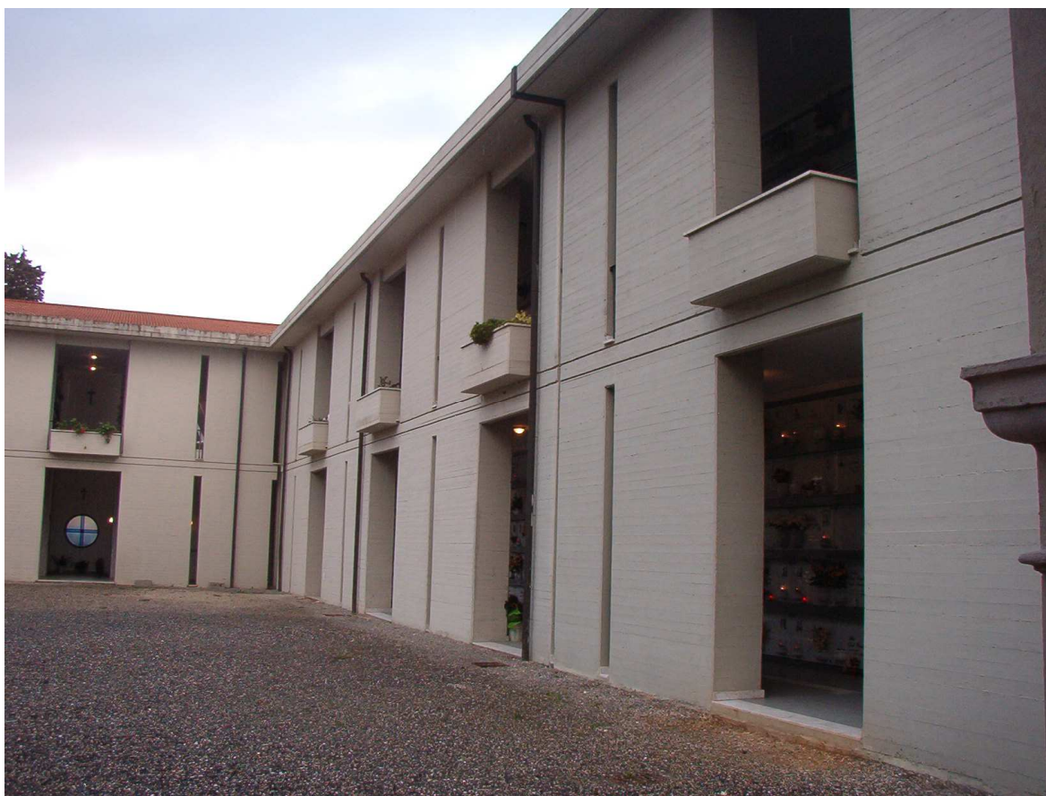
FIGURA 45 – Tipologia fabbricati ala recente del cimitero
