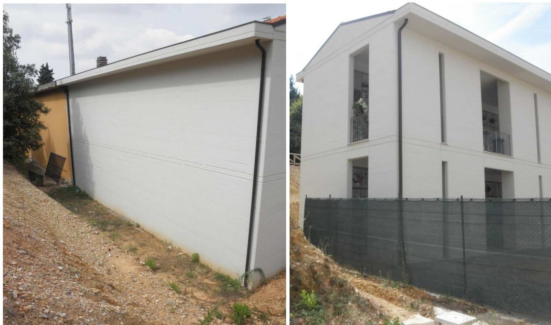
FIGURA 34 – Finitura a “calcestruzzo faccia vista” con cromatismo grigio chiaro tipico dei nuovi ampliamenti del Cimitero Comunale
